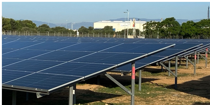
FUENTE: INSTALACIONES CLARIANT
