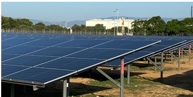
FONT: INSTAL·LACIONS CLARIANT
